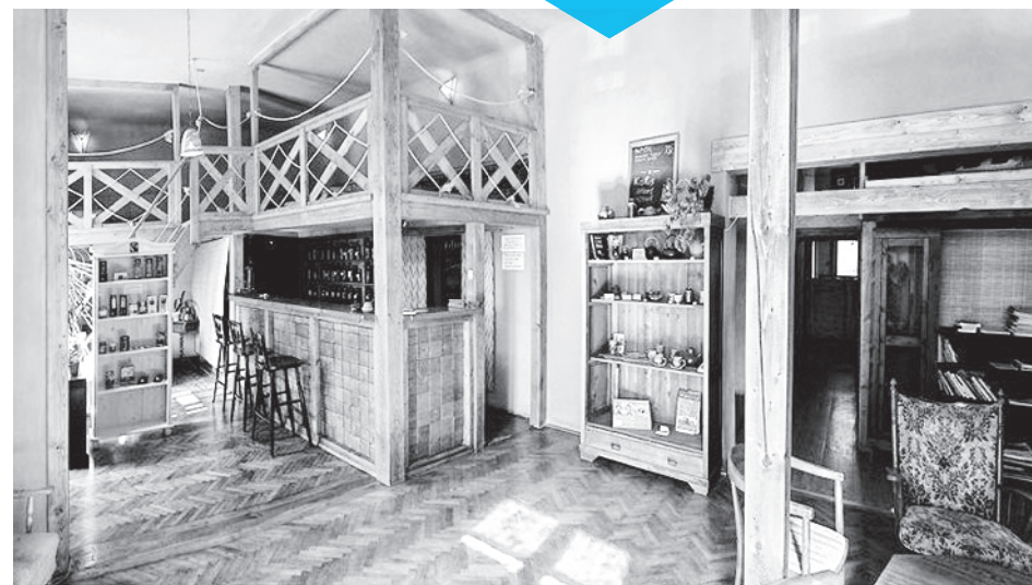
2007 Vznik nového chráněného pracoviště v Čajovně Hóra
